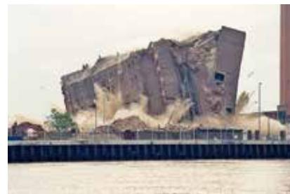
**Figura 2.18** Explosivos que contienen nitrógeno. La dinamita y el TNT (trinitrotolueno) son explosivos nitrogenados que se utilizan para volar rocas en la construcción de caminos o para demoler con eficiencia viejas construcciones.
